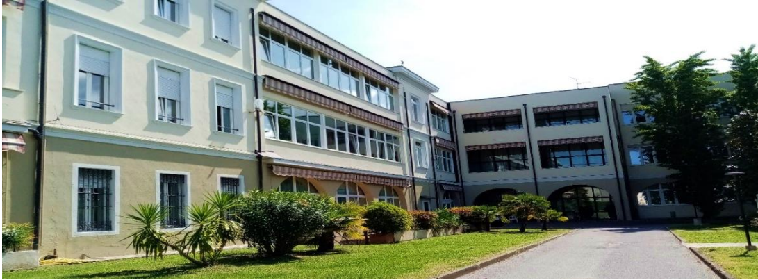
La RSA vista dal cortile interno
